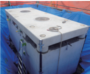
漏れ防止構造 プレコン式 タンクの容量は同じでも躯体の大きさを従来品よりさらに小さくすることができます。
