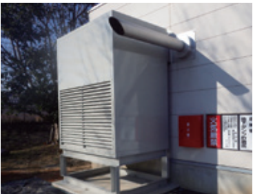
給気排風消音機 85～55dB(A)
