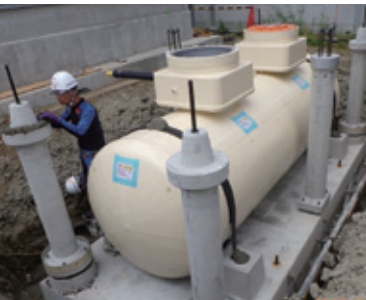
SF二重殻タンク 支柱プレコン式 二重構造になっている地下タンク本体を、支柱式のプレキャスト躯体に組込んで、設置するものです。
